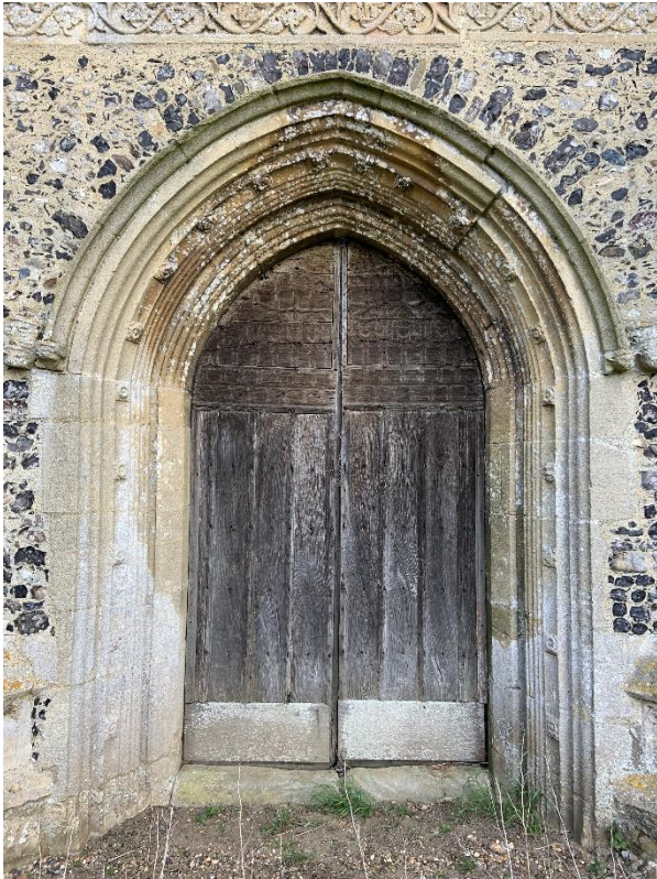
Photo 9. Tower door exterior.
